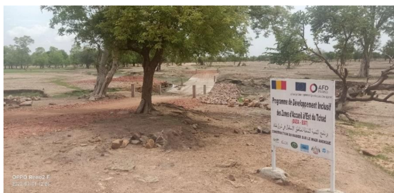
Aperçu d'un radier. Photo : Mahamat Abdelkerim, APLFT, Juin 2022, Province
